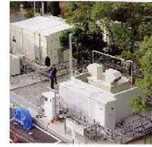
水素供給 ステーション
